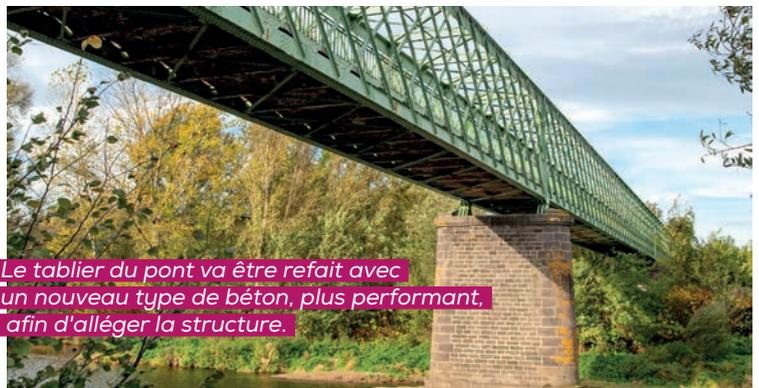
Le tablier du pont va être refait avec un nouveau type de béton, plus performant, afin d'alléger la structure.
